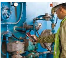
Use el micro CD-100 para detectar gases en aplicaciones de mantenimiento de edificios y plantas.
