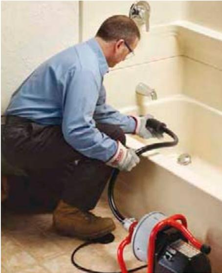
**En la bañera:** diseño compacto que permite un fácil acceso a áreas complicadas como bañeras y armarios debajo de fregaderos, mientras retiene el cable y lo mantiene apartado de todas las superficies acabadas.
